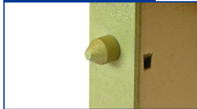
STUD PREVENTS LIFTING
